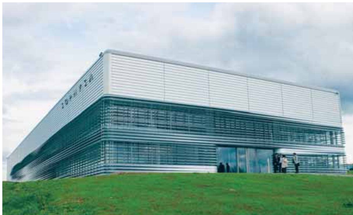
La structure métallique standard s'habille de clins horizontaux sophistiqués, qui s'entrouvrent devant des baies vitrées.
